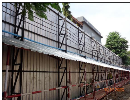
ภาพที่ 3.2.2-2 รั้ว Metal Sheet ตามแนวเขตพื้นที่ก่อสร้างโครงการ
